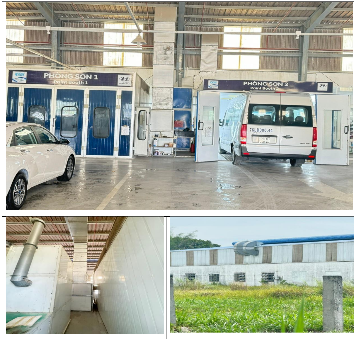
Hình 2.5. Vị trí buồng sơn và đường ống dẫn phát thải khí thải từ phòng sơn
